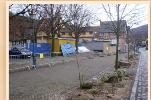
Réfection des WC publics place du Marché (Gouraud)
