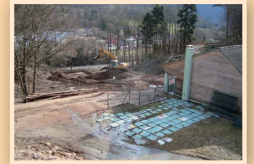
Travaux autour du stand de tir
