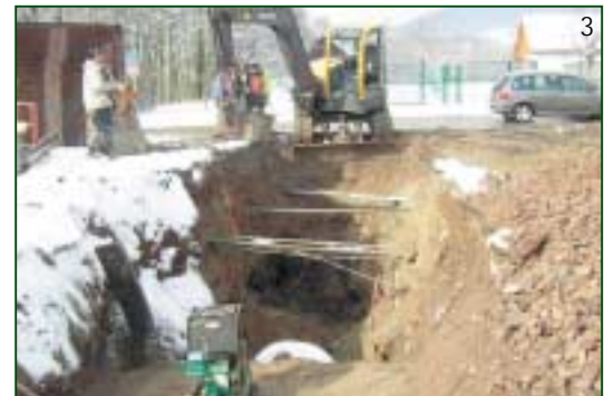
Assainissement rue du Geisbourg (2 et 3).
