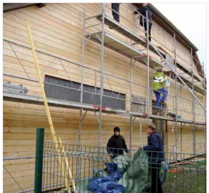
Isolation (fibre de bois + bardage bois) de la façade Nord de l'Ecole Jean Geller
