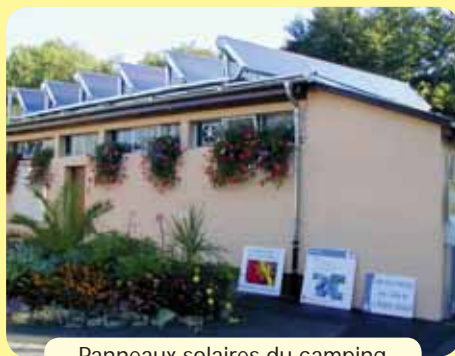
Panneaux solaires du camping
