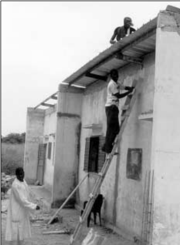
Pose de la nouvelle toiture sur les 2 salles de classes.
