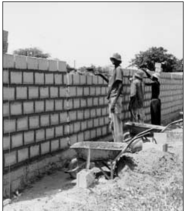
Construction du mur de protection de la cour d'école
