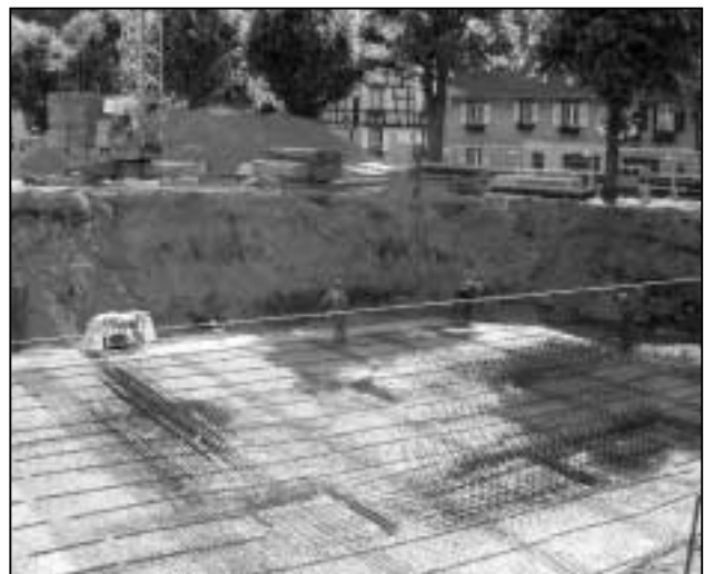
Déversoir d'orage place Gouraud.
