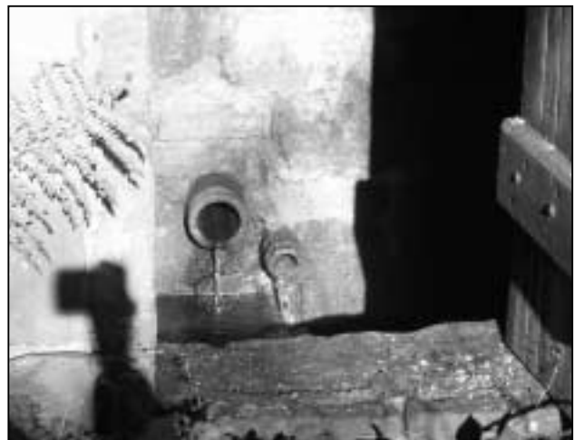
Le captage de la source St-Jean avant les travaux.
