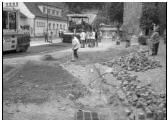
Les travaux place Jaeglé
