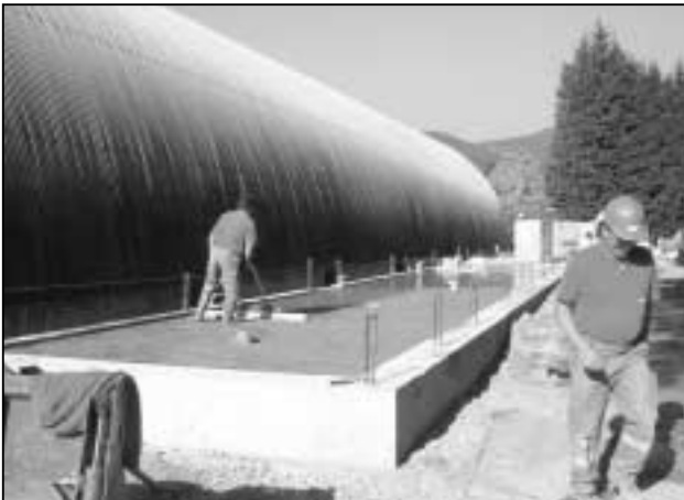
Le nouveau vestiaire en cours de construction.
