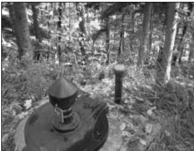
Un brise charge après la jonction des sources St-Jean et Blind.
