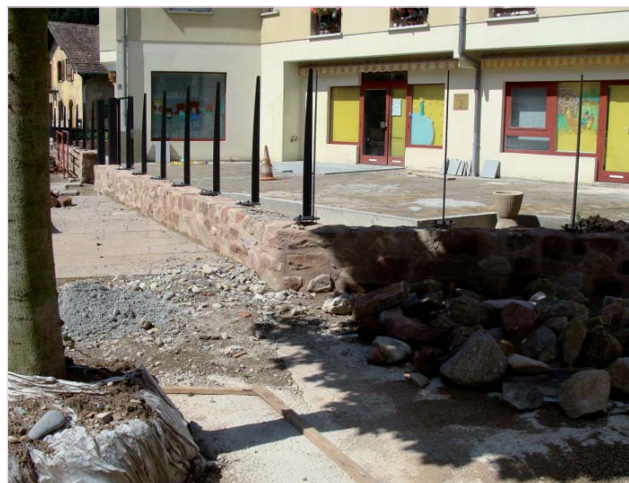
La cour de la crèche en travaux
