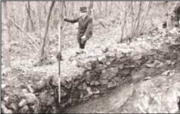
4. Hutte médiévale sur le versant Sud (de l'intérieur)
