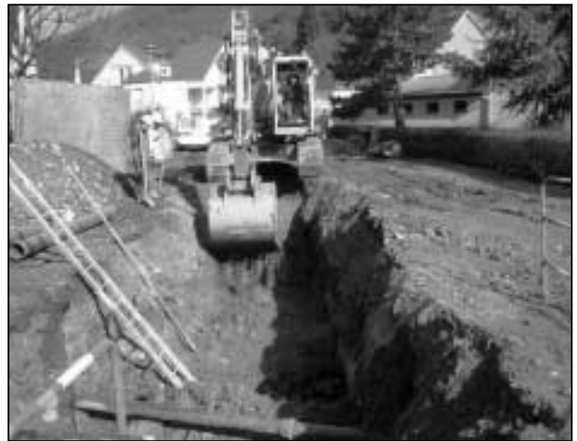
Assainissement Rue du Geisbourg.
