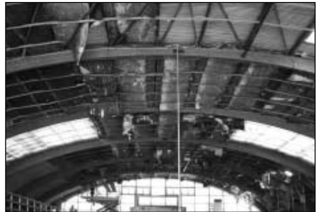
Dépose de la laine de verre.
